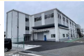
水素ガスタービン関連部品等の測定・評価を実施する研究施設（新規増設）
